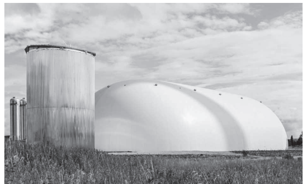
イタリア・サルジニア島に建設された4MWhの実証実験設備
